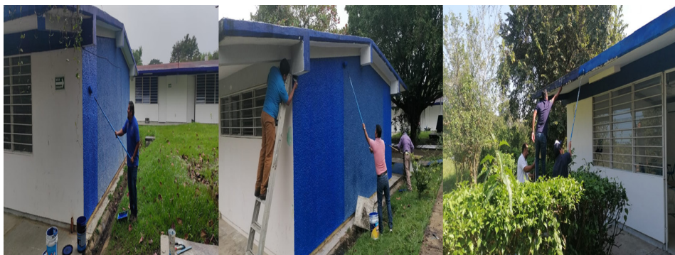
Imagen 19. Mejoramiento de pintura en el edificio F.
