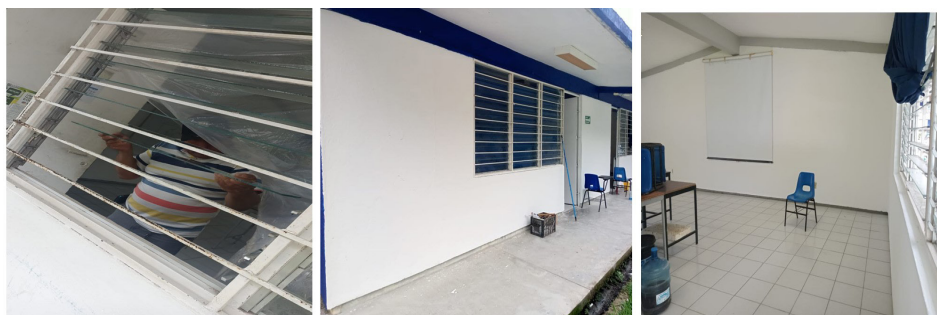
Figura 13. Mejoras realizadas al edificio D.
