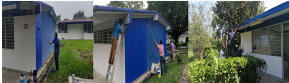
Figura 14. Mejoras realizadas en el edificio F.
