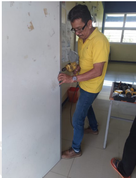
Figura 15. Instalación de cerraduras en el edificio H.
