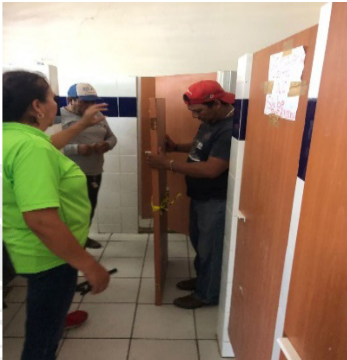
Imagen L. Reparación de las puertas de los baños.
