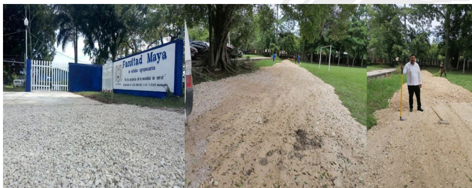
Figura 17. Acondicionamiento de áreas de estacionamiento.
