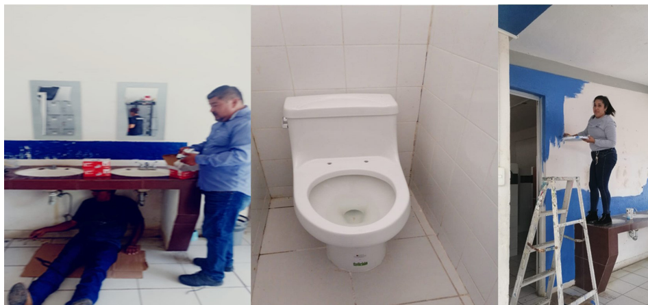
Figura 18. Acondicionamiento y mejoramiento de pintura en baños de la Facultad Maya.
