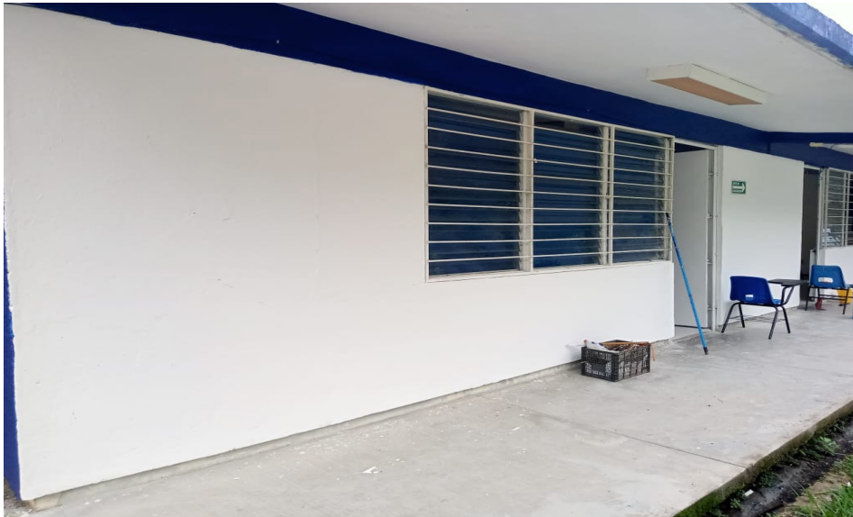
Imagen 15. Mejoramiento de pinturas en el edificio D.
