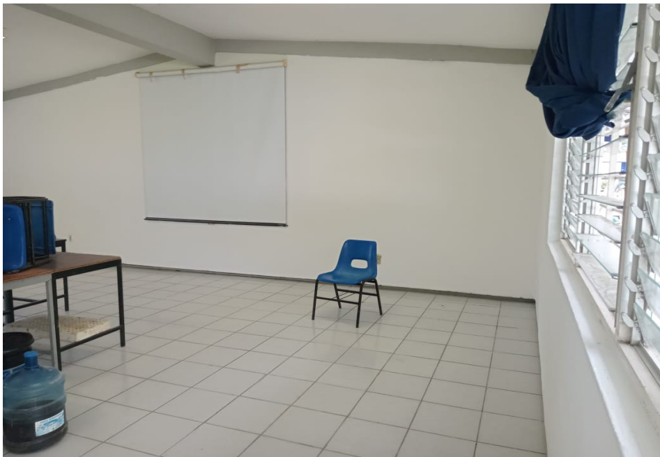
Imagen 16. Acondicionamiento de baldosas en el edificio D.
